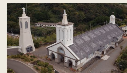
建在能眺望到出津村落山上的 “出津教堂”
