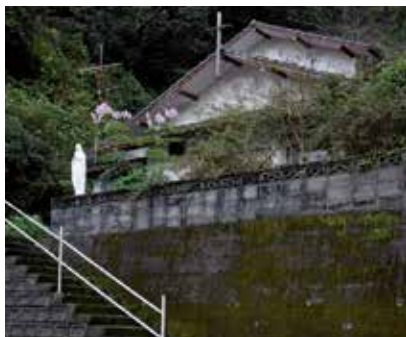
① 建在崎津諏访神社旁的修道院旧址
